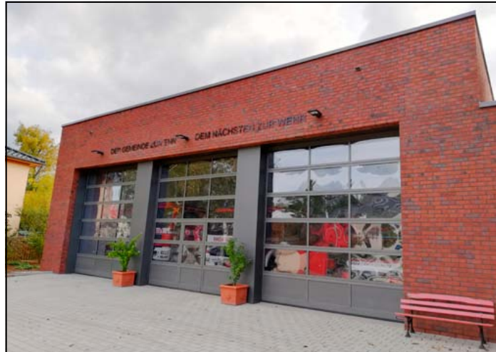
Im September 2020 wurde der traditionsreiche Spruch der Dölauer Floriansjünger über dem neuen Gerätehaus angebracht. Foto: Gabriele Bräunig
